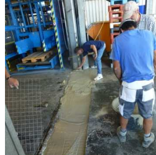
CONCRETE MIX bis 600 mm Auftragsstärke
